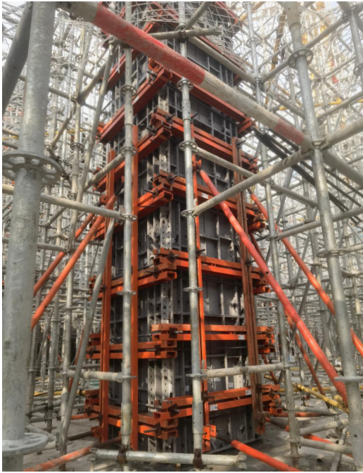
Column Formwork Solution 1 柱模解决方案一
